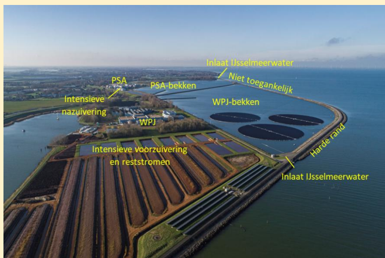
Figuur 10: Luchtfoto van locatie Andijk met de verschillende assets benoemd
