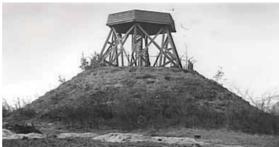
Uitzichttoren de Tafelberg werd gebouwd op een waterleidingreservoir met een inhoud van 600.000 liter water, bestemd voor de drinkwatervoorziening van Blaricum en Huizen.
